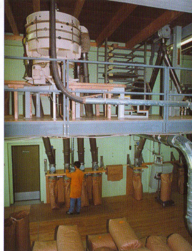
Installation de tamisage dans un grand moulin
